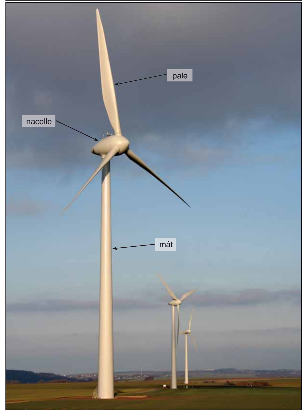
FIGURE 1 : PRINCIPAUX CONSTITUANTS D'UNE ÉOLIENNE
